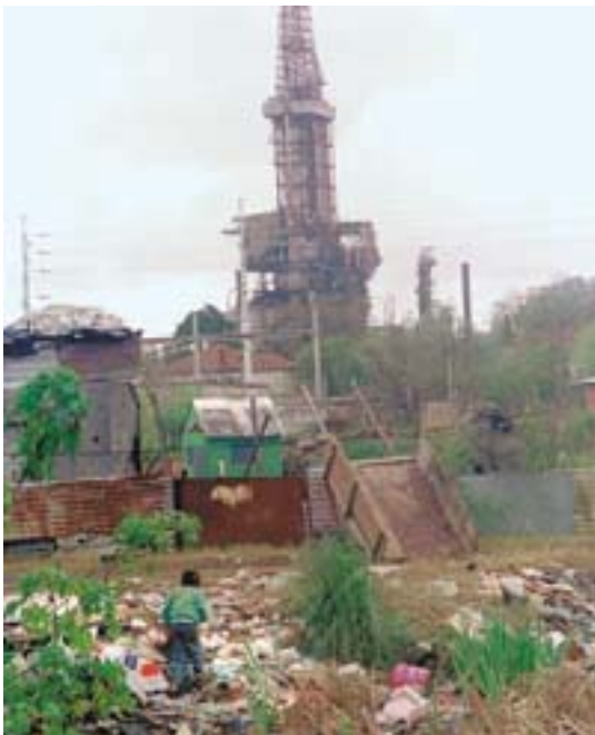
Villa Inflamable. Al fondo de la imagen se observa la planta de coque
